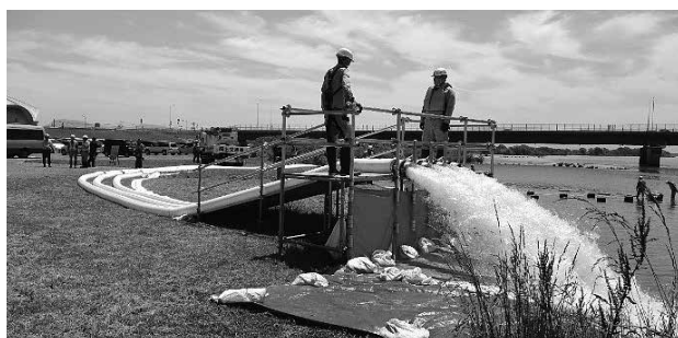
排水ポンプ車による排水作業訓練
