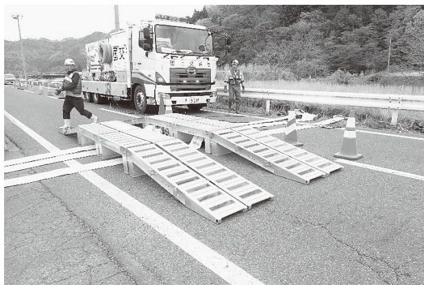
消火用水確保のため排水ポンプ車を設営
