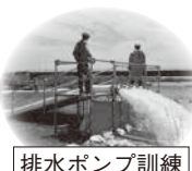
排水ポンプ訓練
