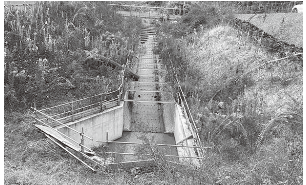
写真-4 川内沢川の切り替え水路
