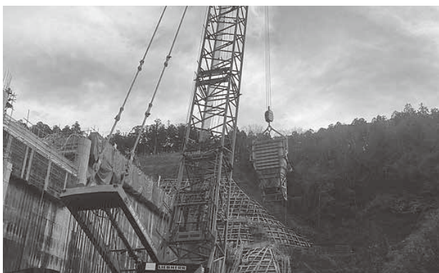
写真-3 4.5m 3 水平バケットによる打設状況
