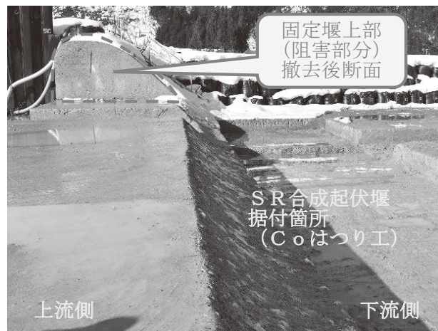
写真-2 固定堰（阻害部分等）撤去状況
