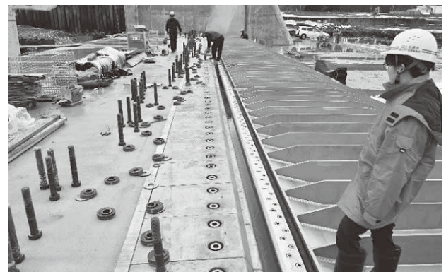
写真-6 扉体固定作業状況
