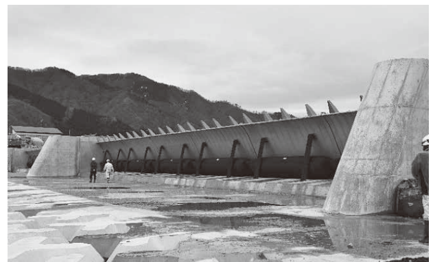
写真-8 ゲート試運転状況
